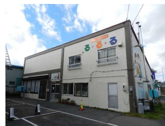
築 30 年ほどの貸し事務所を 改装したという活動拠点
