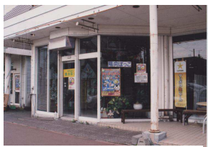
2014年春にも町民福祉の中核・「憩いの館」となる現「陽向ぼっこ」の仮事務所
