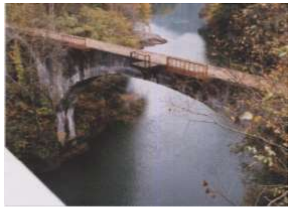
音更川を 32m にわたって結ぶ第 3 音更川の大アーチ橋梁。先人の知恵をしのばせて自然との調和もすばらしい
